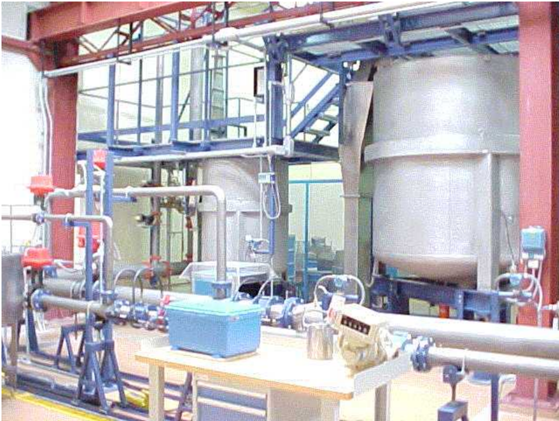
Fig. 2 Vista general del patrón nacional para flujo de líquidos.
